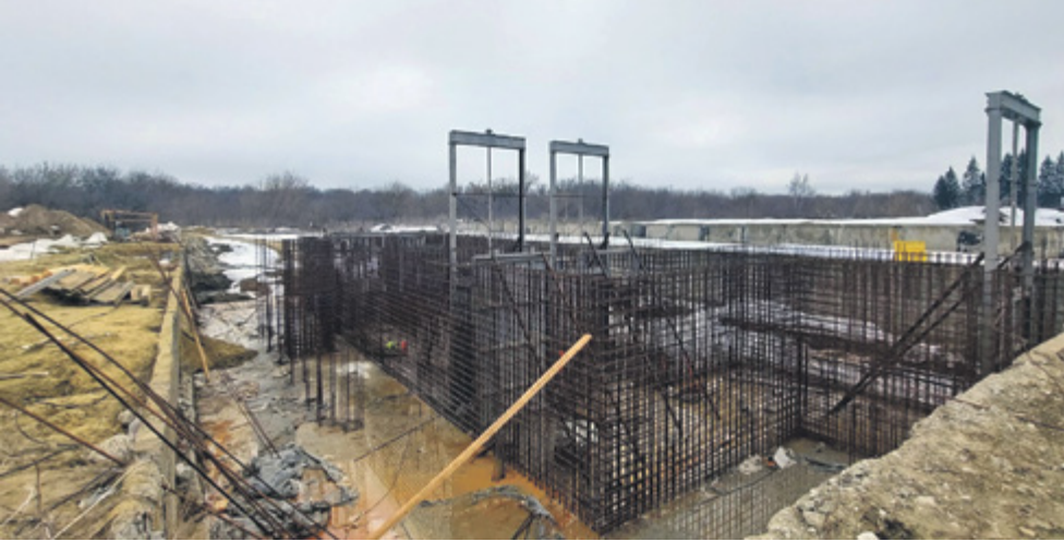
УФ-станция в процессе строительства
