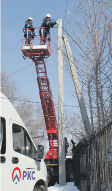
Специалисты техприса АКС подключают новый объект
