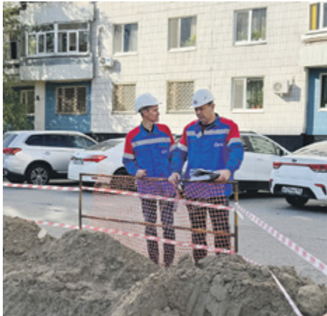
В 2026 году заменят 1,2 км ветхих сетей водоснабжения
